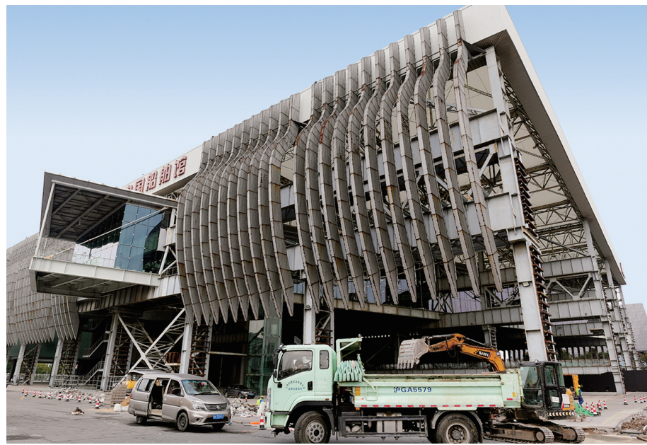
上海工博馆施工现场 林卫平 摄
