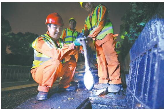
疏通车上的疏通头可以延伸到30米的管道深处对沉积物进行冲刷
