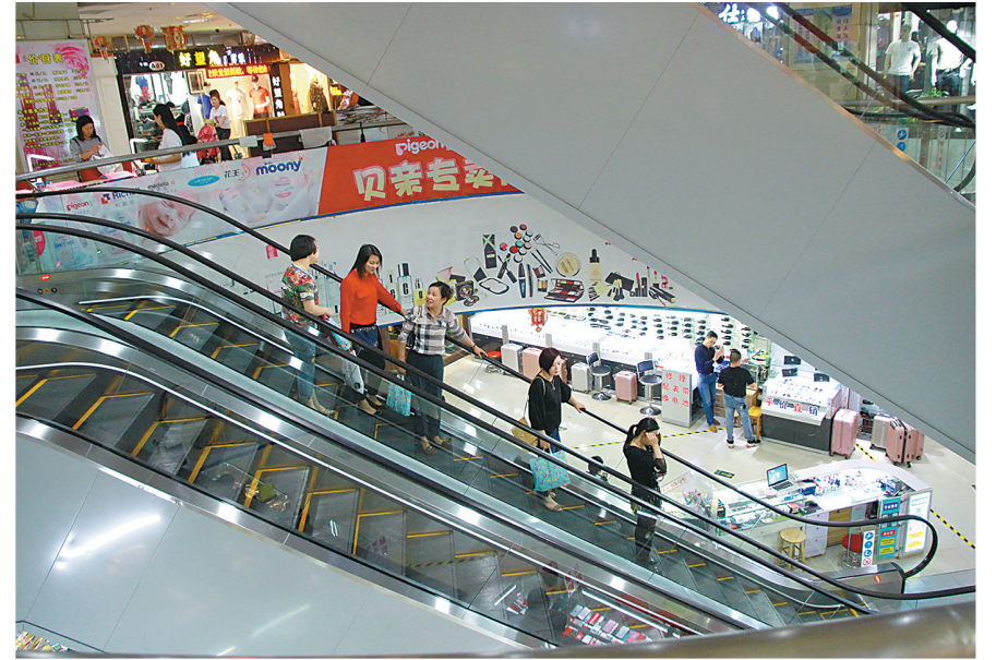
顾客踏上新安装的扶梯
