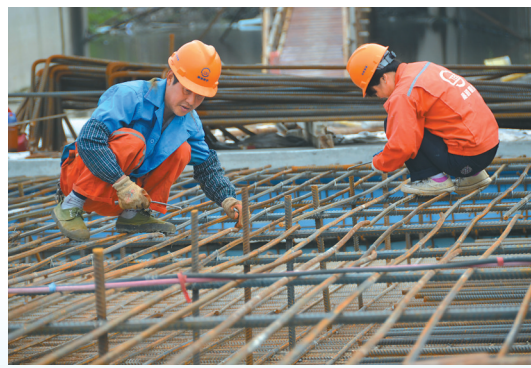
宝幢西侧道路施工
