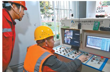
12月17日，位于沙坪坝区陈家桥街道的土主污水处理厂管网扩建工程的建设现场，工作人员在机械顶管智能控制室内操作顶管机进行作业。
