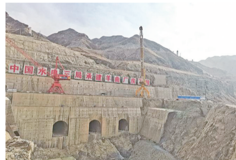
黄河羊曲水电站建设一角
