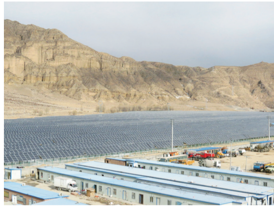
羊曲光伏电站
