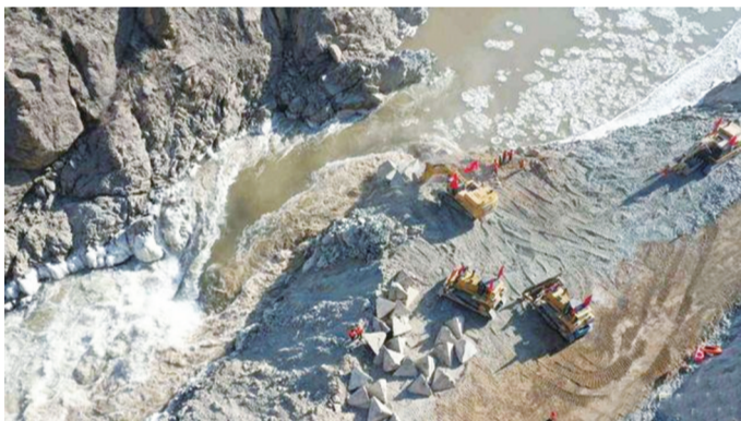
羊曲水电站建设现场
