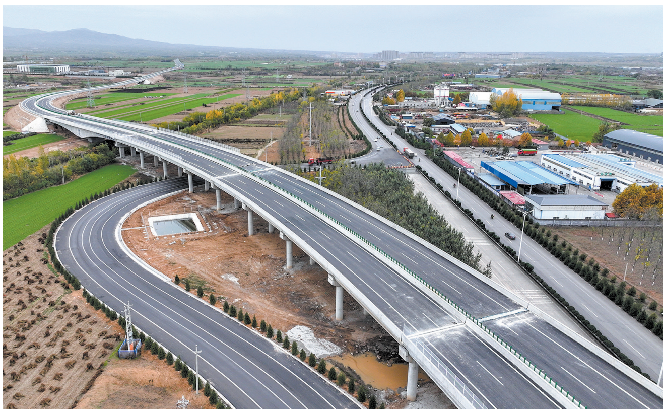
11月19日，在国道108(襄汾—曲沃—侯马)过境改线项目襄汾县张槐村段，项目方在进行收尾作业。连日来，该工程项目部围绕节点，抢抓工期，严控质量，全力开展立柱打桩、波形护栏安装等施工作业，为顺利通车奠定良好基础。
