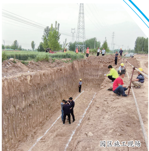
园区施工现场
