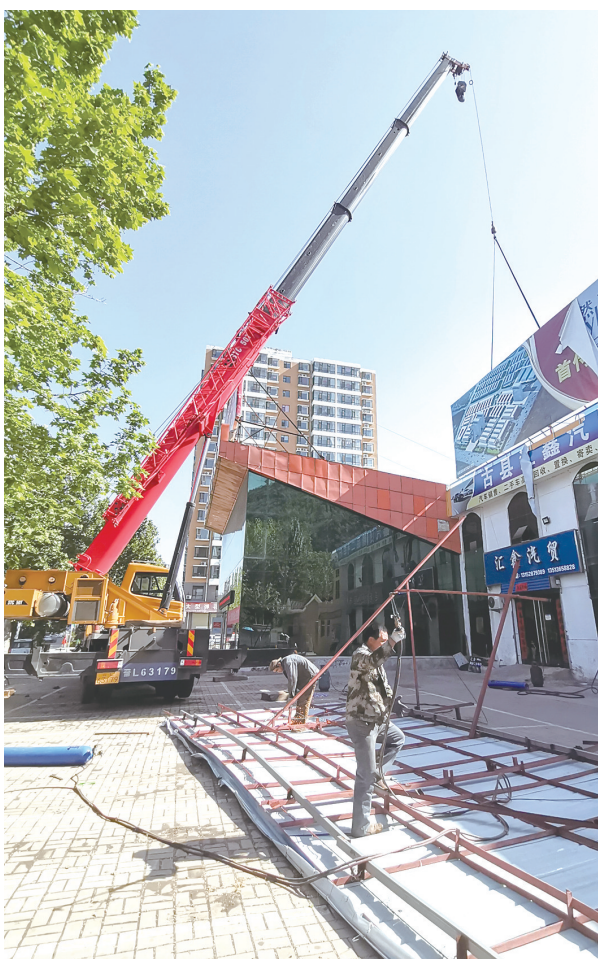
广告下墙工作现场 王彬 摄
