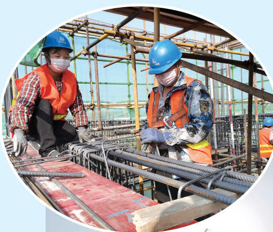
山西师范大学新校区位于我市河西新区，总占地2041亩，分两期实施。其中，一期工程总投资约38.9亿元，于2018年6月正式开工建设。截至目前，一期工程的基础处理全部完成，文科宿舍楼、文科食堂和马克思主义与政法学院主体结构已经完成。 图为施工人员正在加班加点，昼夜施工。 —— 柴云祥 摄
